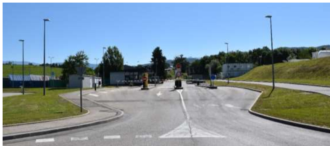
Poste d'entrée/ sortie du site SINERGIE
