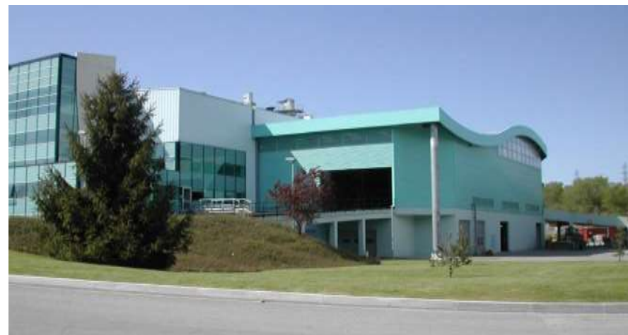
Vue de l'unité de valorisation énergétique
