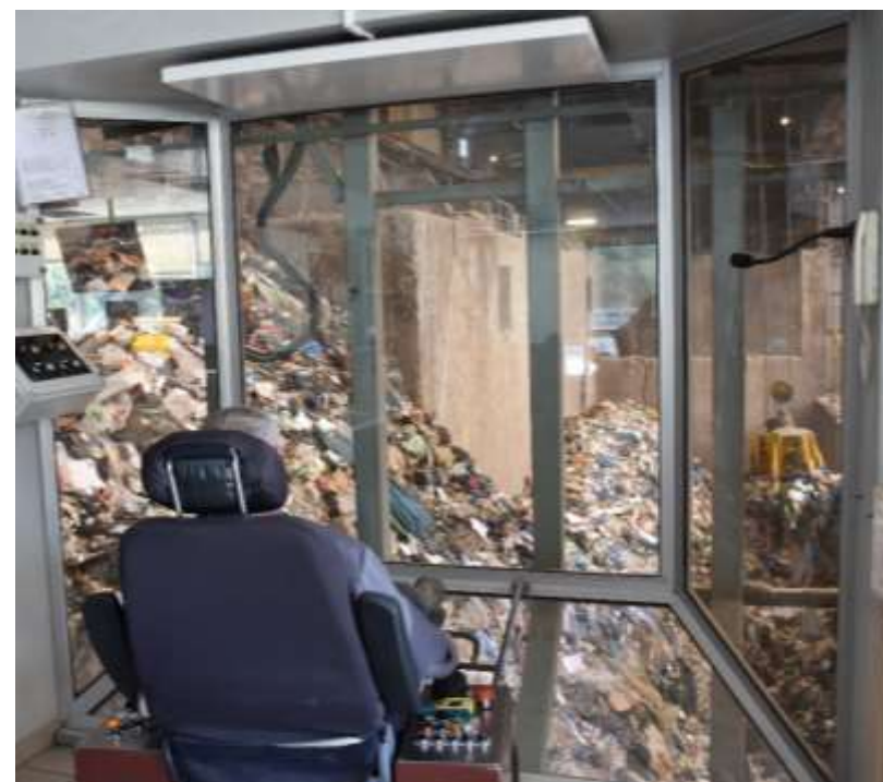
Vue sur la fosse de réception de déchets depuis le poste du pontier
