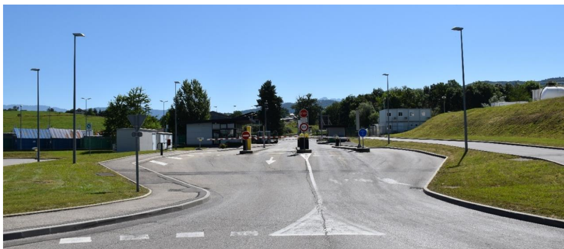
Poste d'entrée/ sortie du site SINERGIE
