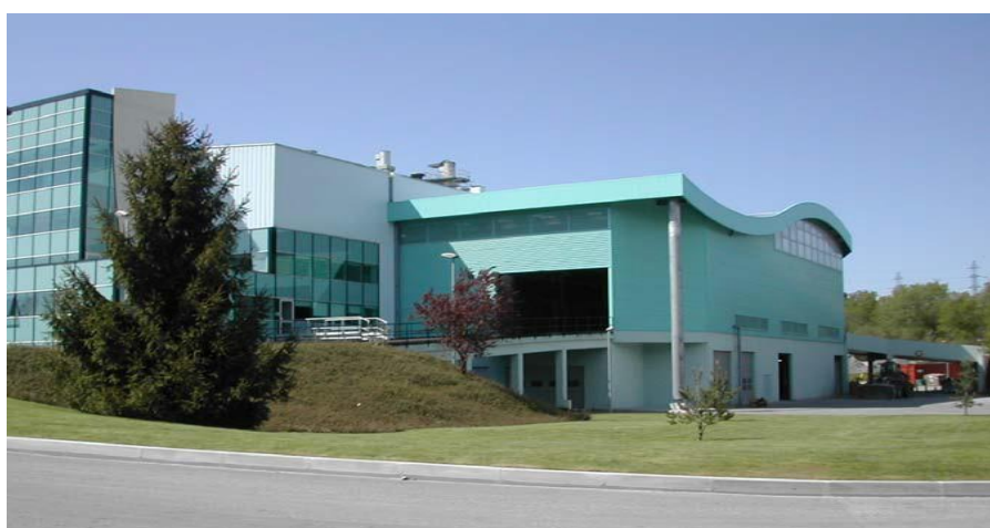
Vue de l'usine de valorisation énergétique
