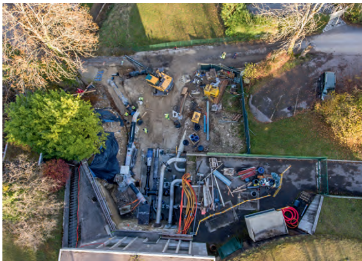
Pose de conduites d'un diamètre très important (50 et 70 cm).
